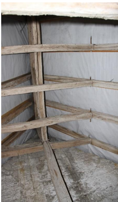
Figure 121. Charpente (2015) avant travaux
