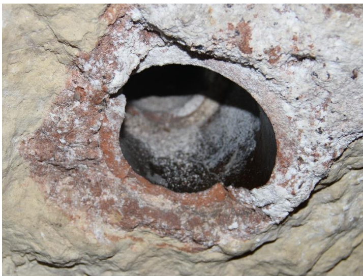
Figure 21. Cette canalisation de terre cuite scellée d'un ciment chargé de brique pilée lui donnant cette couleur rouge est typique de l'époque Gallo-Romaine (source ; manoir des Basses-Rivières)
