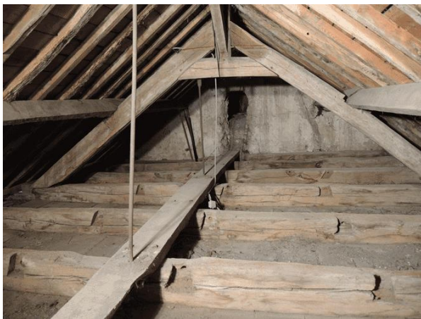
Figure 34. La charpente de la nef de la chapelle Saint-Georges.
