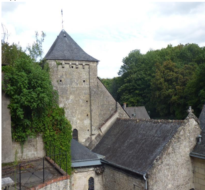
Figure 50 Au Nord Est le clocher; on peut constater la modification de la toiture du chœur, maintenant à un seul pan, et plus haute que celle de la nef, qui n'est pas modifiée.
