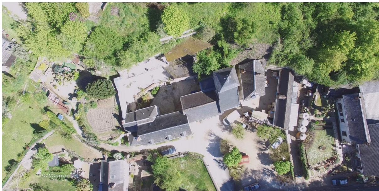
Figure 73. La chapelle et l'ancien presbytère : vue aérienne.
