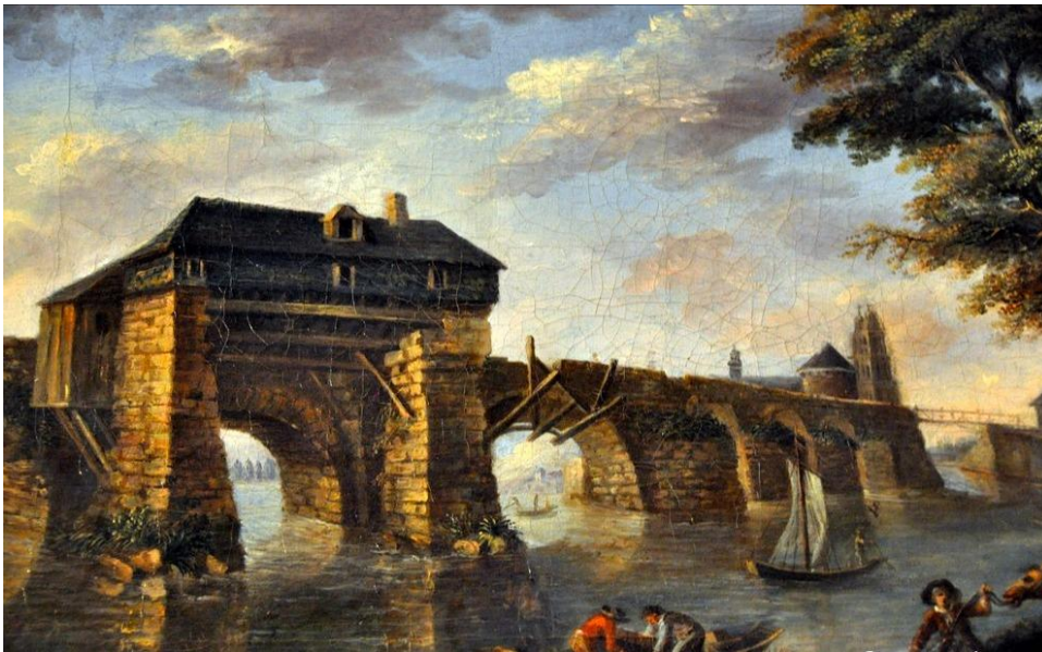
Figure 132. Le pont de Tours (pont de Eudes) en perspective la cathédrale et le château de Tours avec sa Tour de Guise.
