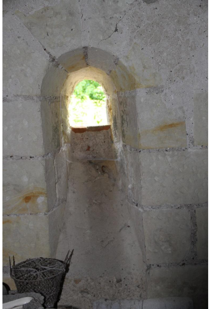
Figure 120. Baie vue de l'intérieur (partiellement obturée)
