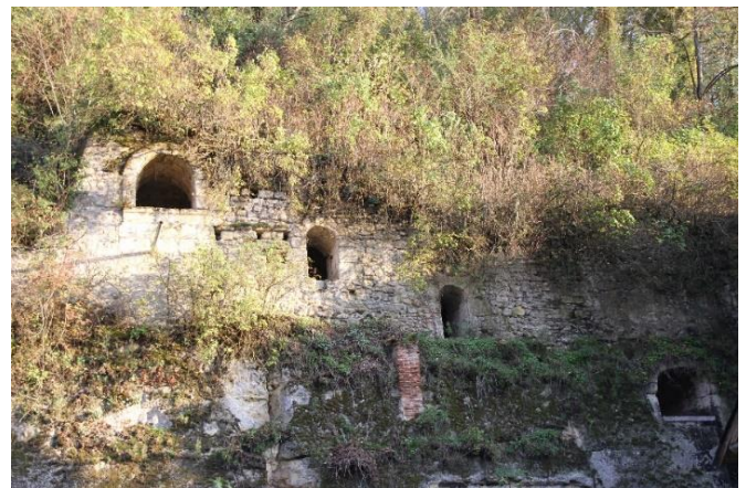
Figure 108. L'extérieur en 2015 : peut-être la moitié de la construction n'existe plus.
