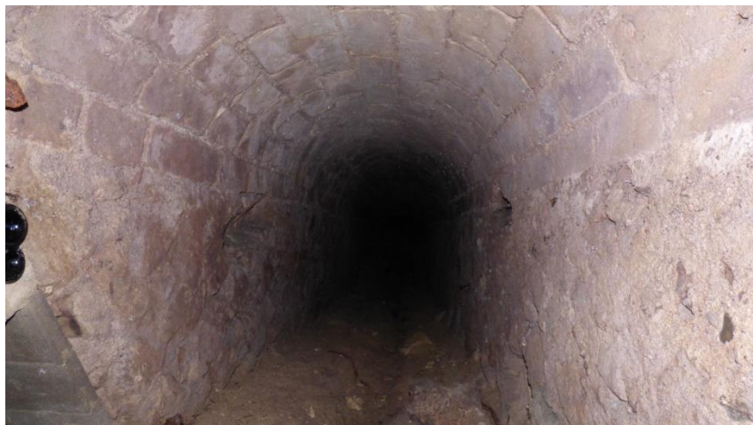
Figure 201 Tunnel de liaison débouchant dans le puits de Rosnay
