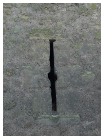
Figure 110. Présence d'étranges meurtrières
