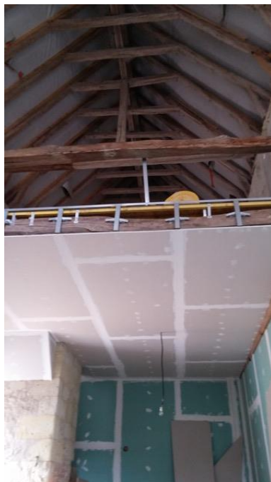
Figure 124. L'intérieur en cours de travaux ; la majorité des entrants a été coupée
