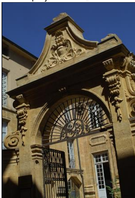
Figure 146. Hôtel de Boyer d'Eguilles à Aix en Provence
