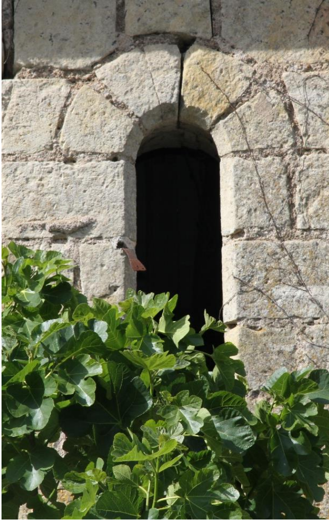
Figure 117. Baie en forme de meurtrière (extérieur)
