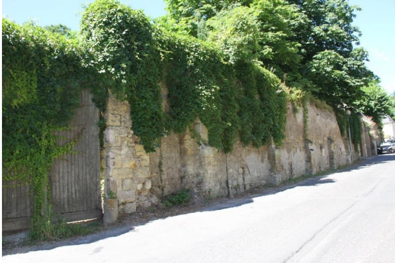
Figure 93. Mur de séparation avec la rue Saint-Georges. Ce mur devait former muraille : ce mur semble avoir été arasé à une période non connue. Au deux extrémités se dressaient deux tours aujourd'hui disparues.
