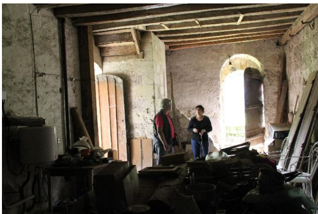
Figure 119. Rez-de-Chaussée de la chapelle avant travaux ; la mezzanine faite au XIII e repose sur les poteaux de bois : au fond, à gauche, l'escalier pour accéder au niveau supérieur
