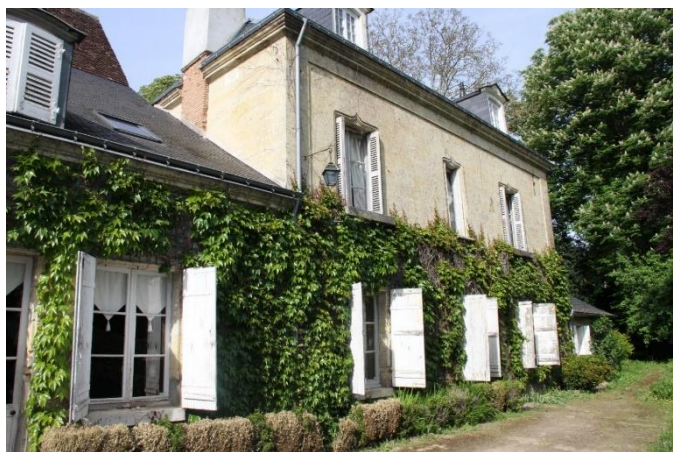
125 La maison accolée à la chapelle en 2015 (avant travaux)
