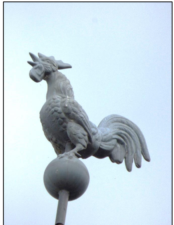
Figure 19 Le nouveau coq au faite du clocher
