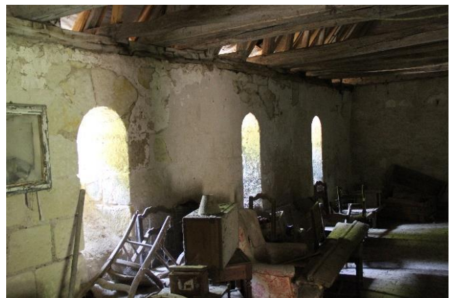
Figure 118. Le niveau supérieur ; la charpente d'origine avec ses entrails, sol en carreaux de terre cuite.
